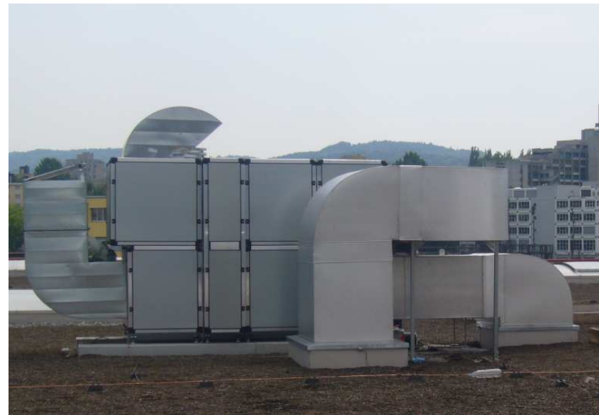
Bauhaus – Schlieren AHU mit Rot. WT
