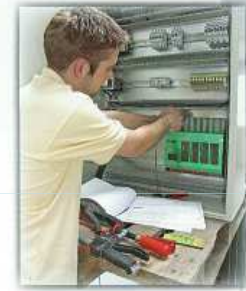
Einbau einer Sauter-Steuerung
