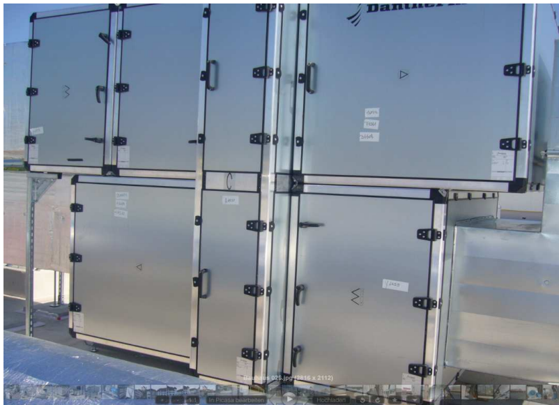
Bauhaus – Schlieren AHU mit Rot. WT
