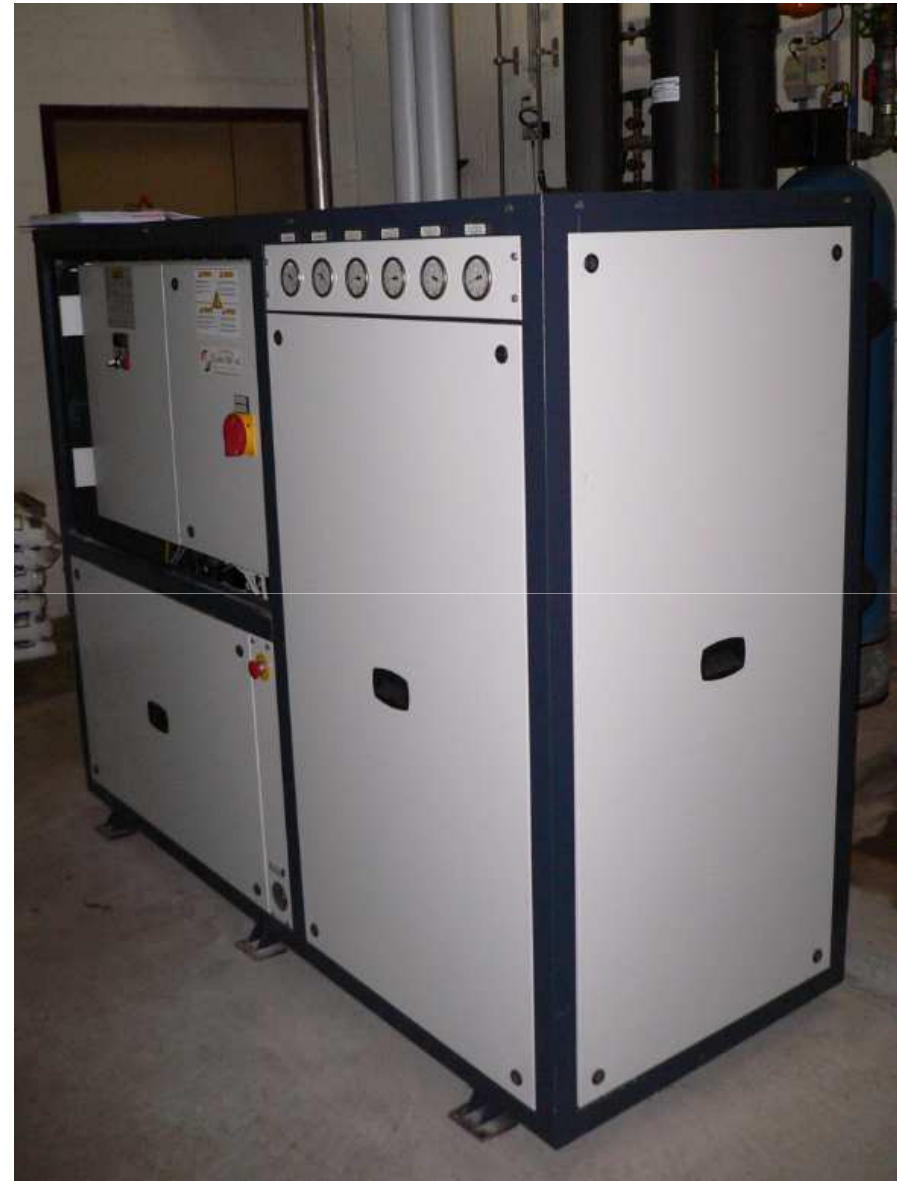
SIKA–Widen Kaltwassermaschine mit Hydronik
