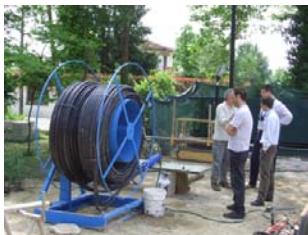
Geothermische Sonde vor dem Einführen
