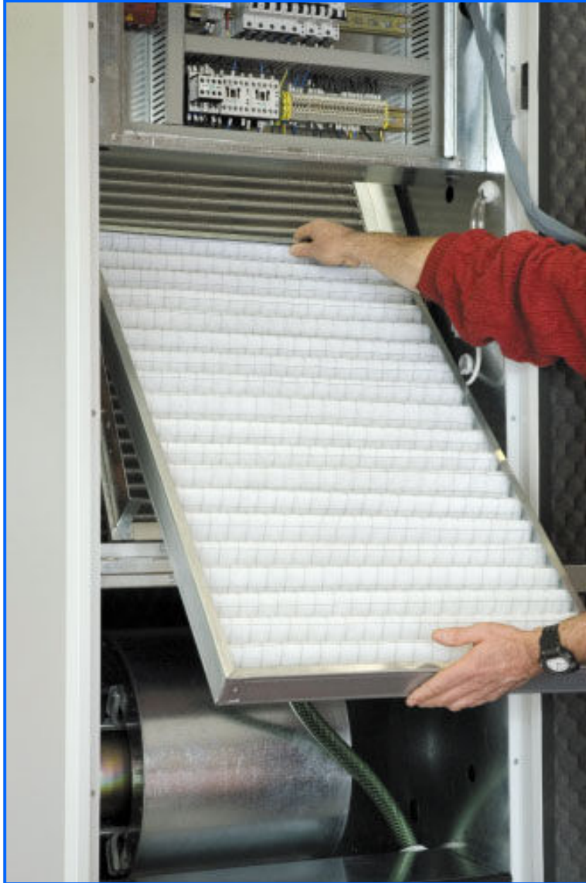
Dettaglio estrazione filtro dell'aria Austausch des Luftfilters
